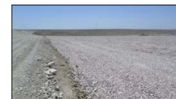
Ampliación vertedero SADECO. Trafisa, S.A. (Ayuntamiento de Córdoba)
