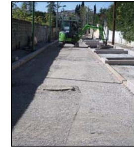
C/ Toledo. Construcciones Ros Zapata, S.A. (Ayuntamiento de Córdoba)
